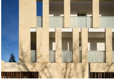
Les façades en béton matricié participent de la structure tout en isolant les loggias aménagées dans le volume général des immeubles.
