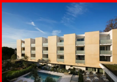
Le rythme des façades en béton alterne avec celui des loggias.
