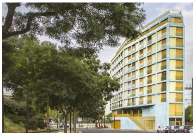
Fin et élancé, le bâtiment s'étire sur la longueur de la parcelle, entre réseau ferré et rue.
