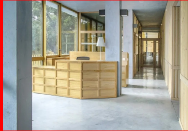
Hall d'entrée du CFA caractérisé par le béton bleu des poteaux, du sol et du plafond.
