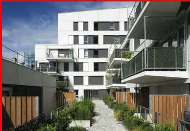
La totalité des logements bénéficient d'un prolongement extérieur privatif dont la superficie moyenne est de 10 m 2 par logement.
