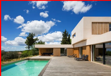
En fond de perspective, la loggia et la cuisine extérieures sont à l'abri du soleil.
