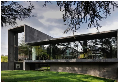
L'enchaînement continu des plans horizontaux et verticaux en béton noir dessine la figure, façonne la volumétrie générale et la spatialité intérieure.
