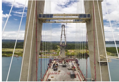
Pendant les travaux, afin d'éviter que les efforts soient trop importants en pied de pylônes, des butons provisoires étaient installés entre les deux jambes.
