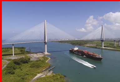
Avec une travée centrale de 530 m, le pont de l'Atlantique détient le record du monde de longueur pour un ouvrage haubané en béton.
