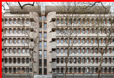
Façade principale rue de la Mouzaïa avec ses « dents de mammouth » en béton qui marquent les niveaux et ses « serre-livres ».
