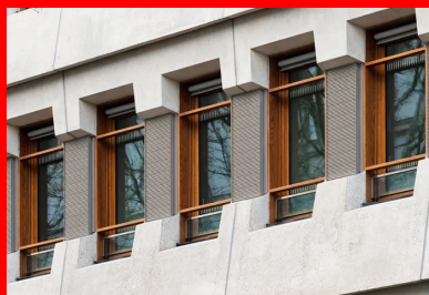
Le béton brut et les menuiseries donnent une apparence domestique aux façades rénovées, dont le dessin est conservé.
