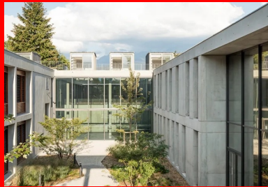
Façade réhabilitée et façade nouvelle forment un tout plus qu'homogène.
