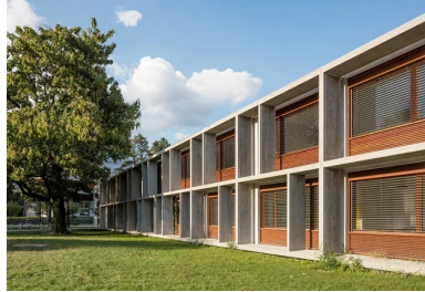
Grâce à une réhabilitation soignée, les façades datant des années 1960 semblent neuves et inchangées.
