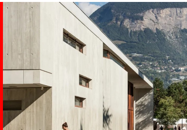
La rugosité du béton brut fait particulièrement écho à la roche des montagnes voisines.
