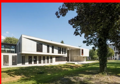
Par leur rythme et le béton brut de décoffrage, les façades de l'extension perpétuent l'esprit du bâtiment d'origine.
