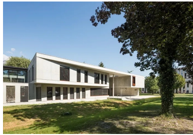
Par leur rythme et le béton brut de décoffrage, les façades de l'extension perpétuent l'esprit du bâtiment d'origine.
