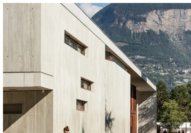
La rugosité du béton brut fait particulièrement écho à la roche des montagnes voisines.
