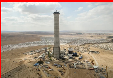
Les dizaines de milliers de miroirs font converger les rayons solaires vers le sommet de la tour.
