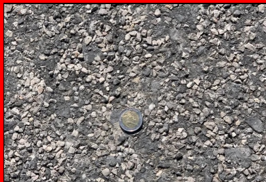
Aspect fini de la plate-forme support.
