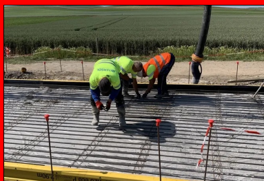
Après avoir posé les armatures longitudinales sur les distanciers, l'équipe les ligature avec un recouvrement de 64 cm.
