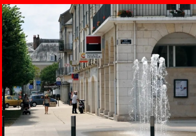
Blois, quai de la Saussayé, sur la rive droite. La rénovation des trottoirs en béton bouchardé s'est accompagnée de travaux d'embellissement. Ici, une fontaine.
