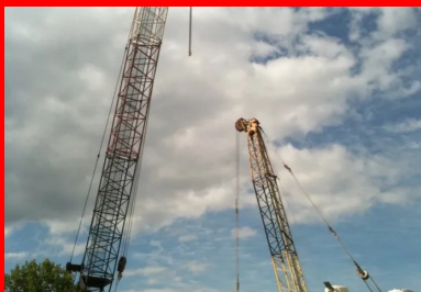
Installations de chantier
