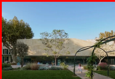
Au rez-de-chaussée de la partie contemporaine, se caractérise une bande vitrée continue de 33 m de long, qui ouvre généreusement l'espace jeunesse sur le parc.
