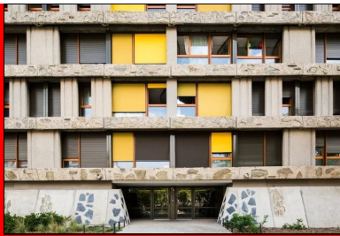
La reconstitution des angles maçonnerés avec inclusion de schiste marque à nouveau chaque entrée.
