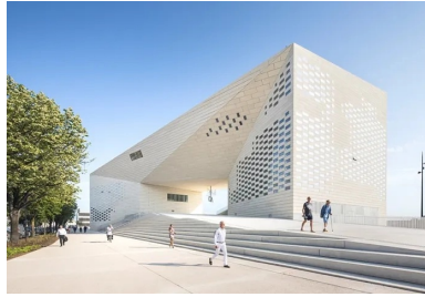
En marches ou gradins, rampes ou plateforme, le socle de la Méca s'apparente à un espace public, singulier par les panneaux de béton clair qui le couvrent à l'unisson des façades.
