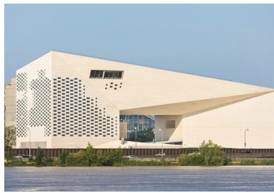
Depuis le fleuve, l'ouverture du volume tempère la massivité du bâtiment.
