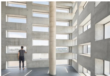
Dans les espaces du bureau, les matériaux sont laissés bruts. L'épaisseur des façades de béton laisse pénétrer la lumière tout en faisant brise-soleil.
