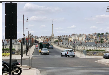
Blois retrouve son lustre historique grâce au béton bouchardé
