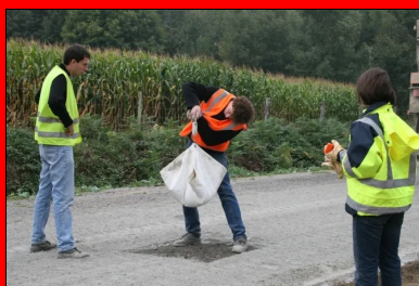
Contrôle de l'épandage à la bêche
