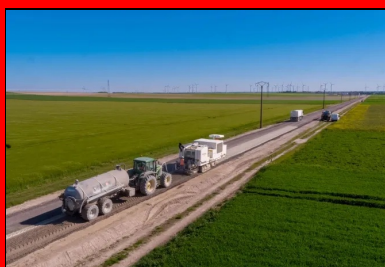
Atelier de retraitement ARC 1000 en action
