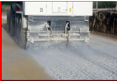
Le liant est épanché pour atteindre l'objectif d'un dosage de 5 %, avec vérification de la quantité épanchée à l'essai à la bâche.
