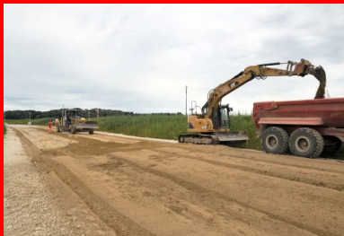
Les déblais, traités à la chaux, stockés et bûchés dans le périmètre du chantier, sont repris pour la réalisation de la couche de forme.
