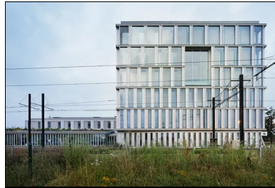
Vue du côté des voies ferrées.
