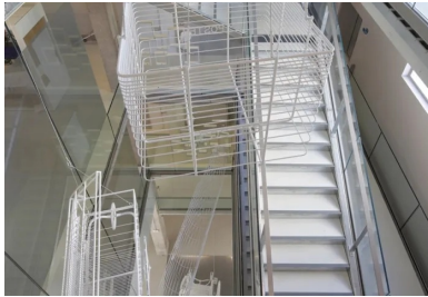
Les volées d'escalier, qui se déploient au bord du vide, mettent en scène les parcours entre les collections.
