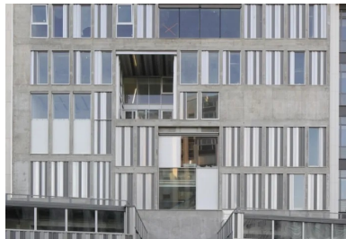
La façade nord ouvre le musée sur le paysage parisien et la lumière. Sa structure d'origine est révélée, réinterprétée et mise en valeur par de grands châssis vitrés verticaux ou des panneaux métalliques.
