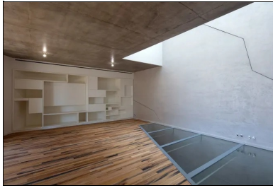
Si la structure poteaux-poutres en béton bas carbone de la maison est assez courante, un soin particulier a été apporté au coffrage des plafonds lasurés.
