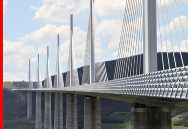
Viaduc de Millau, France - Luca Orniboni on Unsplash
