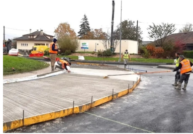
Le balayage, une étape cruciale pour obtenir une bonne PMT, gage d'adhérence sur le long terme pour les véhicules.
