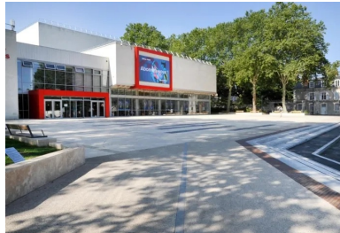
Le nouveau parvis en béton met en valeur la façade rénovée du théâtre. Conçu par le cabinet d'architecture Heudé et Heudé, elle est ornée de deux cubes rouges : l'un au niveau de l'entrée et l'autre accueillant un écran LED de 30 m 2 annonçant la programmation.
