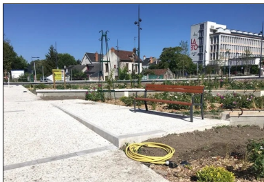
Les cheminements en béton du Jardin des plantes ont été réalisés en mars et avril 2019. Signe particulier : ils sont en béton blanc intégrant de gros granulats de calcaire local O/60 (Pontijou, près de Blois), avec une finition bouchardée.
