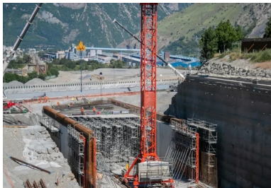
Les traverses supérieures de la tranchée couverte sont coulées en place à partir de tours d'étaie.
