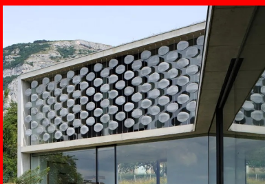
À l'étage, un moucharabieh contemporain, composé de pièces en béton fibré à ultra hautes performances (BFUP), protège l'intimité des espaces privés et réduit l'impact solaire sur les grands vitrages.
