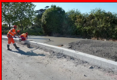
Talochage de la surface du béton.
