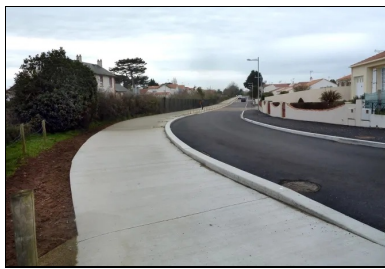
Vue de l'avenue Gilbert-Burtot avec le nouveau revêtement de chaussée.
