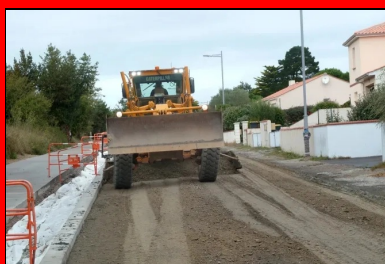
Réglage du matériau retraité à la niveleuse.
