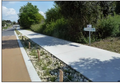
L'avenue Gilbert-Burtot a désormais une piste cyclable bidirectionnelle sécurisée par une noue et une chaussée recalibrée, renforcée et renouvelée. Le béton clair de la piste cyclable contraste visuellement avec la chaussée et rend plus lisible l'espace urbain.
