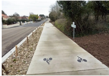
Vue de l'avenue Gilbert-Burlot après requalification.
