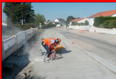
Excécution des joints de retrait par sciage.
