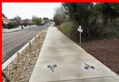
Vue de l'avenue Gilbert-Burlot après requalification.
