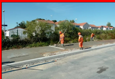
Vibration superficielle du béton.
