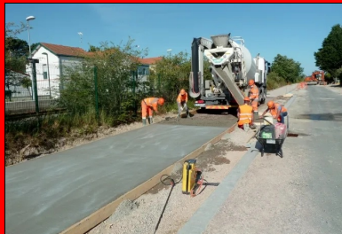
Coulage du béton.
