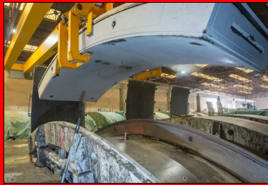
© ACTOPHOTO Après étuvage des moules pour accélérer la montée en résistance du béton, chaque pièce est démoulée à la ventouse.
