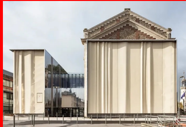
À l'opposé, le drapé de béton habille l'émergence de la cage de scène agrandie.
