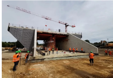
Une fois la brèche créée dans le remblai ferroviaire, le parcours de ripage a été scalpé à la bonne cote, afin de permettre à l'ouvrage de glisser sans effort excessif. Le ripage proprement dit a alors pu se dérouler : huit heures ont été nécessaires pour faire parcourir au pont-rail de quelque 6 500 tonnes les 49 mètres qui le séparent de son emplacement définitif.
