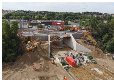
Une fois le pont-rail dans sa position définitive, la plateforme ferroviaire, déjà préchargée sur l'ouvrage (ballast et panneaux de voies), a été raccordée aux plateformes en attente de part et d'autre de la brèche. Parallèlement, les derniers remblaiements latéraux ont été effectués. Finalement, l'OCP s'est achevée avec une heure d'avance sur le planning !
