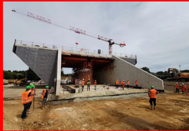
Une fois la brèche créée dans le remblai ferroviaire, le parcours de ripage a été scalpé à la bonne cote, afin de permettre à l'ouvrage de glisser sans effort excessif. Le ripage proprement dit a alors pu se dérouler : huit heures ont été nécessaires pour faire parcourir au pont-rail de quelque 6 500 tonnes les 49 mètres qui le séparaient de son emplacement définitif.
