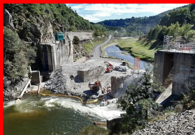
Les travaux de Génie Civil ont commencé par l'arasement des deux piles et du seuil.
