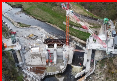
L'ouvrage en béton qui descend à droite est le nouvel exutoire de dévalaison situé en aval du barrage.
