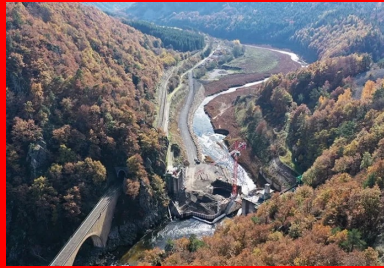
Vue aérienne du chantier sur le barrage de Poutès, dans le Haut-Allier.
