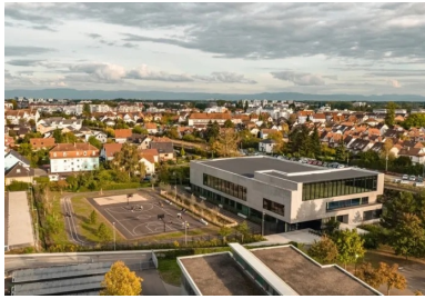
Vue aérienne du gymnase dans son environnement. © CloudyProd
