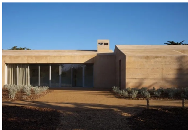
Vue de la façade, côté jardin.
