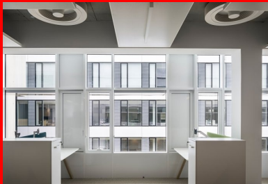
Les plateaux en open space et les grilles de ventilation en façades permettent en été de faire circuler l'air frais dans les bureaux pendant la nuit. Grâce à l'inertie du béton, les frigos stockées sont restituées en journée.
