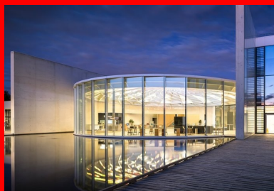
La coupole du hall rotonde reçoit une œuvre lumineuse de Yann Kersalé.
