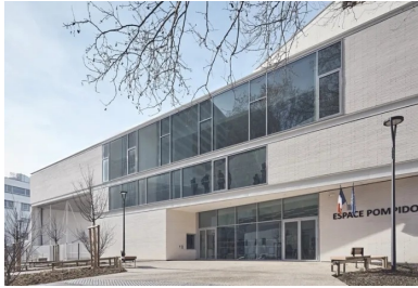
Sous le porte-à-faux créé par le retrait de la façade au rez-de-chaussée, une grande paroi vitrée invite à entrer.
