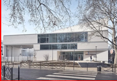
La façade sur la rue de l'Industrie, largement publique et institutionnelle, confère une identité forte au lieu et l'ancore durablement dans son contexte.
