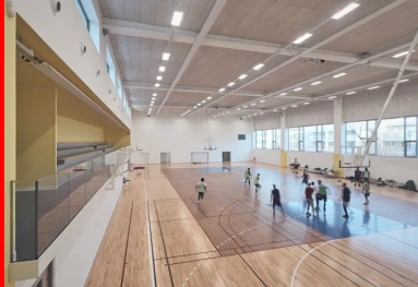
La toiture légère de la salle omnisports est portée par des poutres en béton reprises par des poteaux du côté de la façade sur la rue Ficatier et par une grande poutre-voile située au-dessus des gradins.
