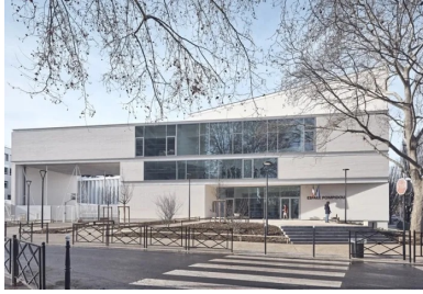
La façade sur la rue de l'Industrie, largement publique et institutionnelle, confère une identité forte au lieu et l'ancre durablement dans son contexte.
