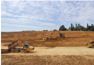
Les matériaux sont repris sur le stock à l'aide d'une pelle sur chenilles et de tombereaux articulés, puis mis en œuvre sur 40 cm par des bulls assistés par GPS
