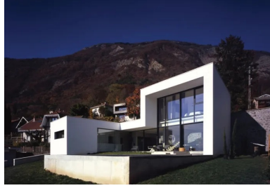
Le volume de la maison est façonné par un enchaînement continu de parois verticales et horizontales en béton recouvertes d'un enduit blanc.
