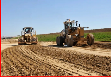
Compactage au Tamping SP2.
