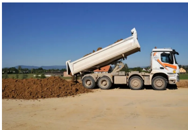
Acheminement des matériaux depuis le dépôt provisoire et mise en place sur site pour une épaisseur finale de 35 cm.
