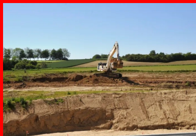
Les techniques utilisées ont permis le ré-emploi de la majorité des déblais du chantier afin de préserver les gisements locaux.
