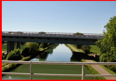
L'A355 se caractérise par une densité élevée d'ouvrages d'art. Ici un exemple de franchissement de canal.
