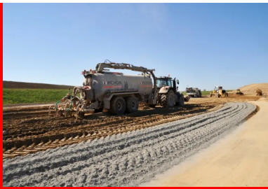
L'arroseuse à enfouissement garantit une teneur en eau optimale.
