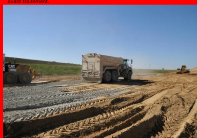
Après scarification, épanchage du liant hydraulique routier.
