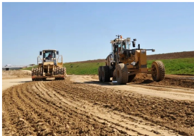
Compactage au Tamping SP2.
