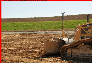
Préréglage à l'aide d'un bull asservi GPS afin d'obtenir une épaisseur homogène avant traitement.
