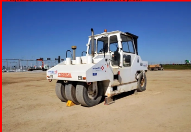
Trois types de compacteurs se sont chargés du compactage afin d'atteindre l'objectif q3 fixé : à bille lisse, à pieds dameurs et à pneus.
