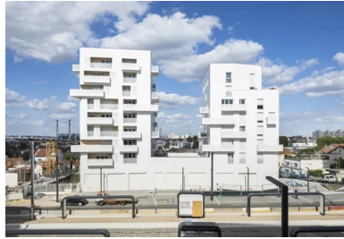
Sur l'avenue, les volumes hauts donnent sa dimension urbaine à l'immeuble.
