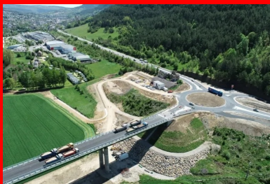
Vue aérienne de la culée C0. Le viaduc du Lot est l'ouvrage d'art principal de la future rocade ouest de Mende (en arrière-plan, le centre-ville). ©DREAL Occitanie
