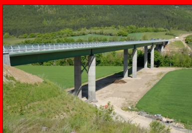
Vue d'ensemble du viaduc. Long de 323 mètres, le tablier de l'ouvrage s'appuie sur quatre doubles piles en béton armé, dont la plus haute atteint 22 mètres de hauteur. ©DREAL Occitanie
