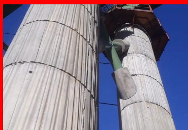
Pile en cours de construction. Les deux fûts sont entretoisés par une croix tubulaire métallique. Bien que reprenant des charges, cette croix répond d'abord à une finalité esthétique. ©CEREMA
