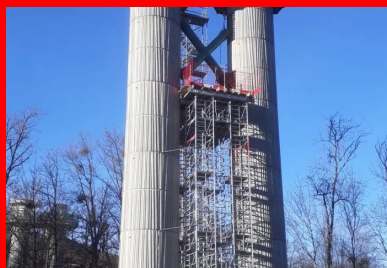
Une double pile en cours de construction. Les fûts des piles, coulés en place dans des coffrages elliptiques, sont ornés d'un motif en béton matricé. ©CEREMA
