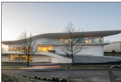
Entre rez-de-jardin et premier étage, l'accès à l'entrée principale par une rampe suit la topographie du site.
