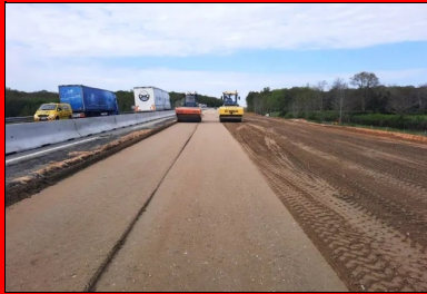
Compactage à l'aide de compacteurs à bille lisse.
