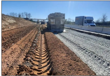
Les matériaux issus des déblais ont été répandus sur le site à l'aide d'une niveleuse, sur une épaisseur homogène. Puis un épandeur asservi a procédé à l'épandage du LHR Ligex M4.
