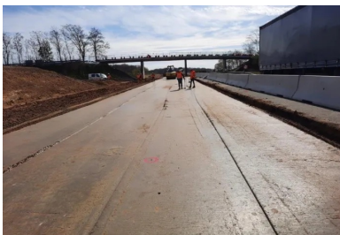
Contrôle du compactage au gamma-densimètre.
