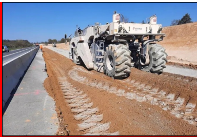
Malaxage à l'aide d'un pulvimixeur.
