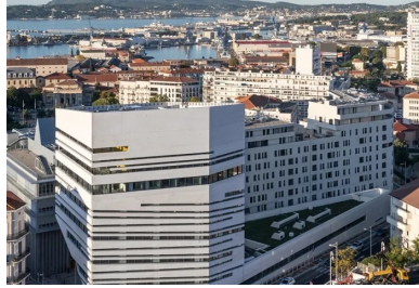
Volumétriquement, le bâtiment est composé d'un socle et d'un plot qui s'élève pour aller chercher la vue. Une alternance de pleins et de vides découpe la façade en lanières, comme un prisme sculpté dans la masse.
