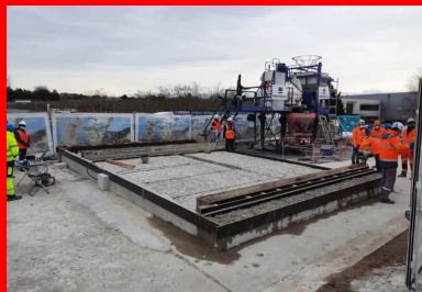
Dalle de convenue après hydrodémolition (photo Freyssinet). Ce modèle réduit de la dalle du pont a été créé pour accompagner le bon déroulement du chantier. Pour valider les performances d'adhérence de l'étanchéité BFUP sur son support béton, des essais destructifs ont été réalisés sur cette dalle. Les résultats sont impressionnants : les éprouvettes ne cassaient pas à l'interface BFUP/béton, mais dans la masse du béton de dalle ! Autrement dit, la couche de BFUP crée un ensemble totalement monolithique avec la dalle existante.
