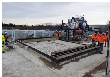
Dalle de convenance après hydrodémolition (photo Freyssinet). Ce modèle réduit de la dalle du pont a été créé pour accompagner le bon déroulement du chantier. Pour valider les performances d'adhérence de l'étanchéité BFUP sur son support béton, des essais destructifs ont été réalisés sur cette dalle. Les résultats sont impressionnants : les éprouvettes ne cassaient pas à l'interface BFUP/béton, mais dans la masse du béton de dalle ! Autrement dit, la couche de BFUP crée un ensemble totalement monolithique avec la dalle existante.
