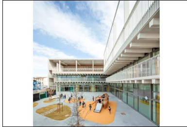
De grands châssis coulissants permettent d'ouvrir de plain-pied les locaux sur la cour de la maternelle ou un large balcon au 1er étage.
