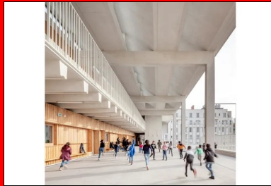
Vue du préau double hauteur.
