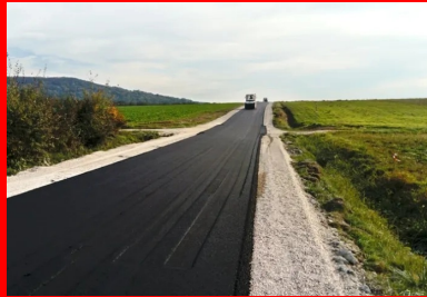
Compactage du BBCS. Mise à niveau des chemins d'accès aux parcelles agricoles.
