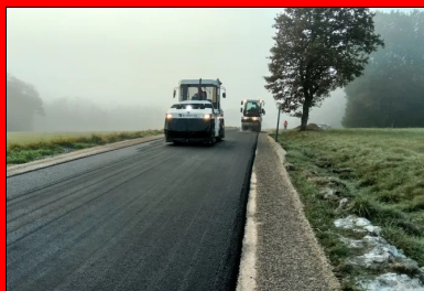
Atelier de compactage du BBGS.
