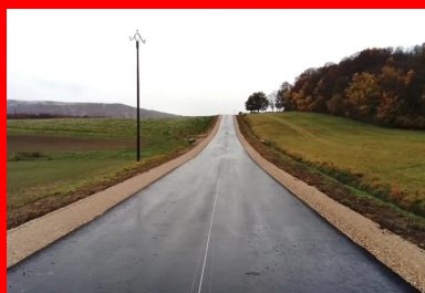
Réhabilitation de la RD25 achevée. Accotement réhaussé et axe de prémarquage réalisé.
