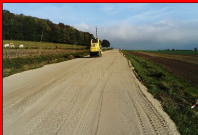
Mise en œuvre de la couche d'assise en gravier non traité.
