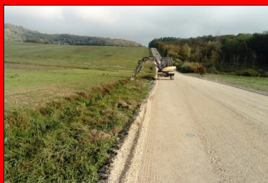
Réalisation des fossés latéraux.
