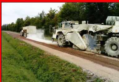
Chaussée rabotée et élargie à 6,60 m. Atelier de prétraitement en place à la chaux en action.
