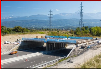
Passage à faune « Porte de Savoie » à Chignin, sur l'A43. Compte tenu de la largeur des ouvrages, le voile de la pile centrale est ajouré. © Régis Bouchu ACTOPHOTO
