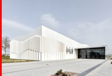
Le décalage des deux volumes aménagés au sud un généreux parvis qui donne accès au hall de l'équipement.
