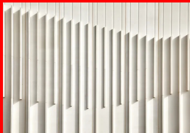
Le parement brut des panneaux est rythmé par des lignes en léger creux et des lames en relief, créant des mouvements, des ondulations, qui animent les façades.
