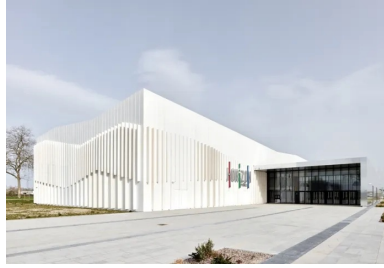
Le décalage des deux volumes aménagés au sud un généreux parvis qui donne accès au hall de l'équipement.
