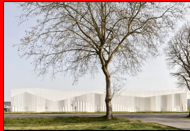
Les façades de la salle sont réalisées avec des panneaux préfabriqués en béton blanc de type mur à coffrage intégré (MCI), qui assurent de façon performante la protection acoustique de l'environnement extérieur.
