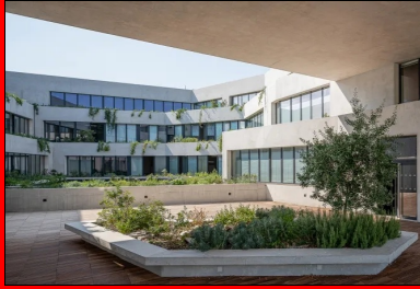
Vue intérieure depuis la terrasse du R+1.
