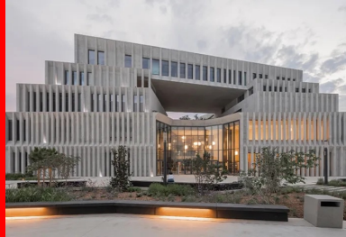
Façade ouest - entrée principale du campus Georges Méliès.
